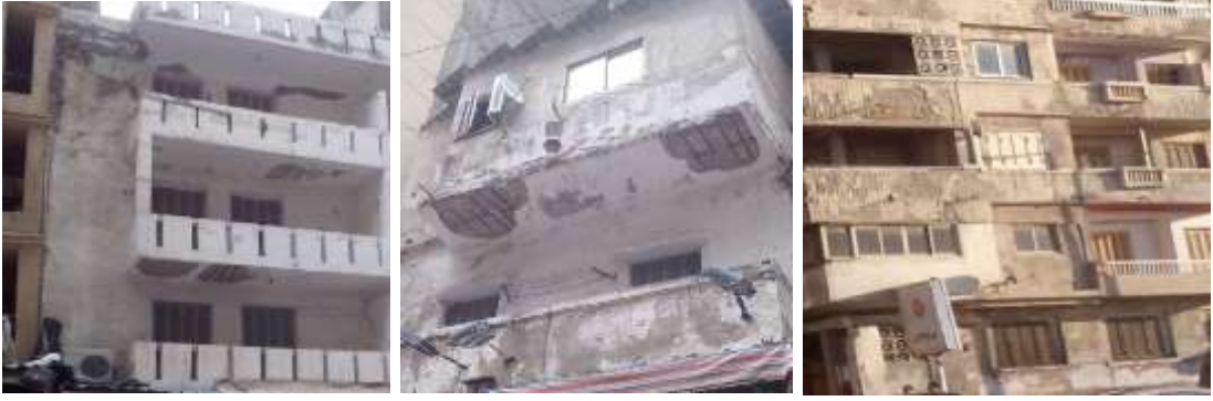
شكل (٢) صور توضح مظاهر التآكل والتشوه على الواجهات المعمارية الساحلية
