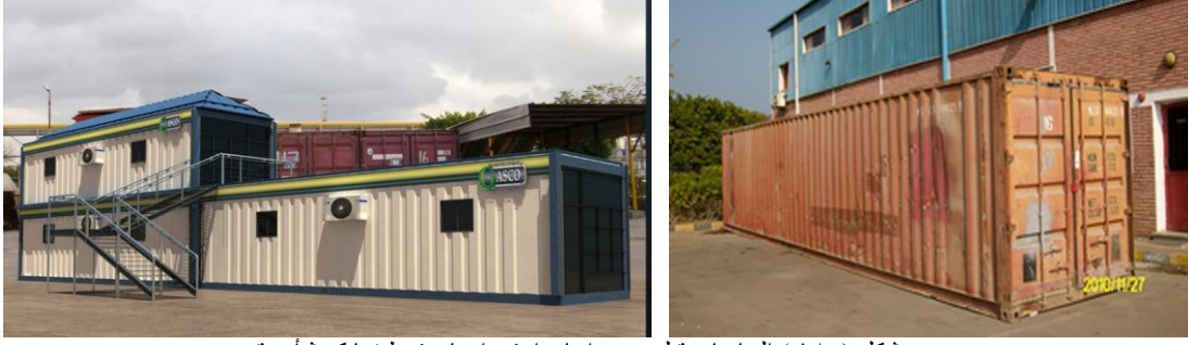
شكل ( ١٨ ) الحاويات قبل و بعد اعادة استخدامها و توظيفها كمنشأ مؤقت
