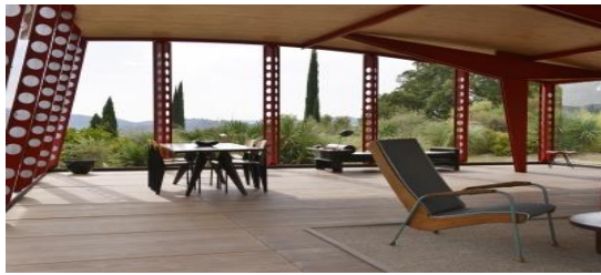
شكل (١) نموذج للمنشآت المؤقتة ( فصل دراسي متنقل ) Jean Prouvé, Temporary School of Villejuif بناء خفيف الوزن يمكن تجميعه بسرعة، وسوف تصلح ليجري تفكيكها وإعادة نصبها في أماكن أخرى المواصفات. ( الدعائم صفائح من الفولاذ ، سقف الخشب الرقائقي المنحني) .
