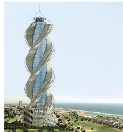
شكل ( ١٩ ) تصميم Diamond Tower, Jeddah على المديول الشبكة ثلاثى الابعاد 3d http://dilemma-tallest-s
