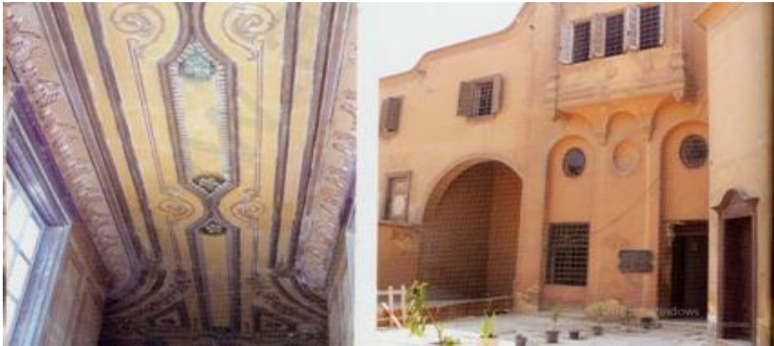
صورة (٤) جزء من سقف القصر
