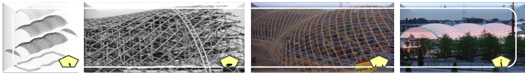
شكل (٥) الجناح الياباني بمعرض هانوفر ٢٠٠٠ ل- شيجيروبان: صور لمراحل تشييد هيكله القشري بقطاعات انبوبية ورقية
