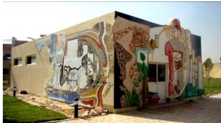
شكل (٢٢- أ) يوضح الفكرة التصميمية لمعمل الاحياء بالقرية الكونية ومدى الاستفادة من الطبيعة والاحياء في تشكيل المبنى
