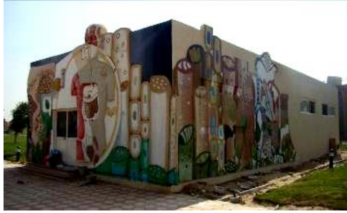
شكل (٢٢- ب) يوضح الفكرة التصميمية في اطار التطبيق لمعمل الاحياء - القرية الكونية ، المبنى من منظور من الجهات المختلفة
