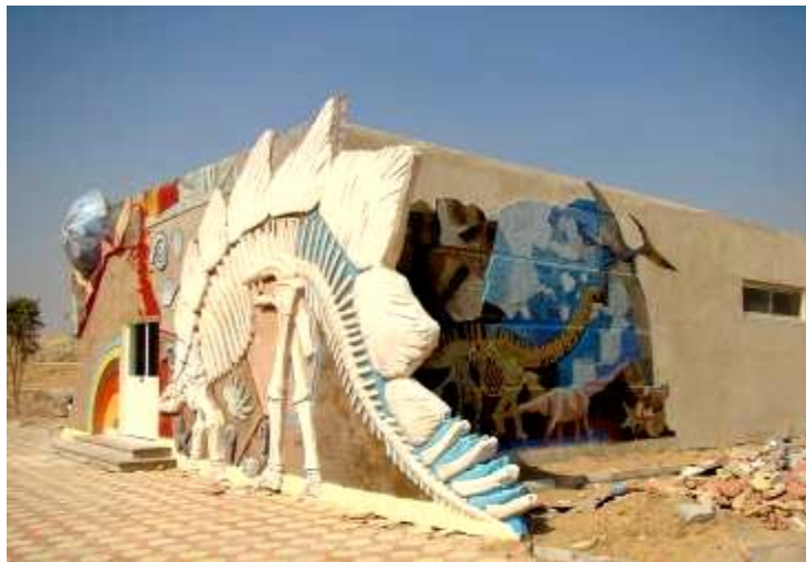
شكل ( ٢١ - ب ) يوضح الفكرة التصميمية في اطار التطبيق لمعمل الجولوجيا - القرية الكونية ، المبني منظور من الجهات المختلفة
