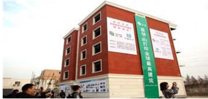
شكل رقم (٢١) لأحد المنازل بالصين تم بناءه بالإنتاج ثلاثي الأبعاد
