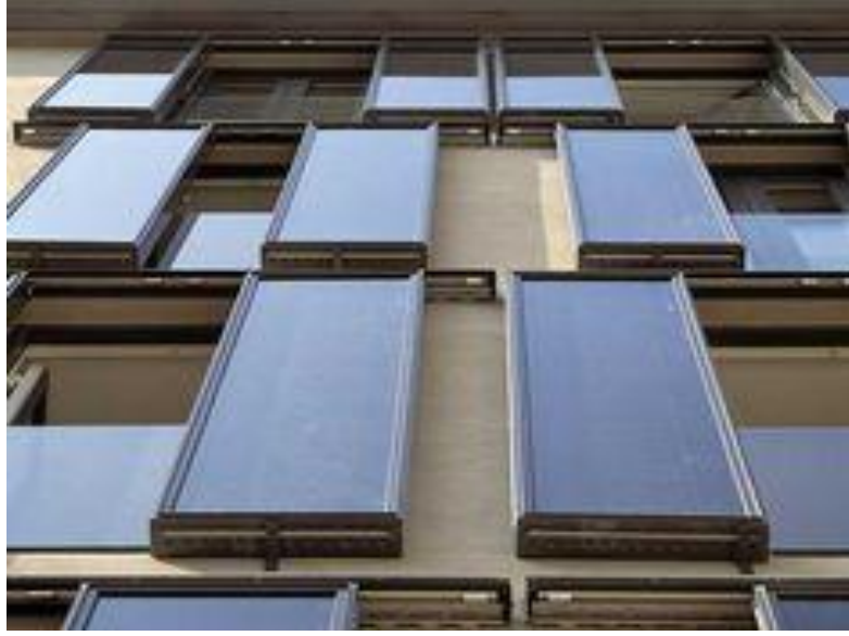
صورة (٦) الألواح الشمسية و التوليد الشمسى للكهرباء ، المثبتة على الدلف المتحرك إقياً (المنزلقة) لفتحات النوافذ بأحد الواجهات المعمارية (١) .
