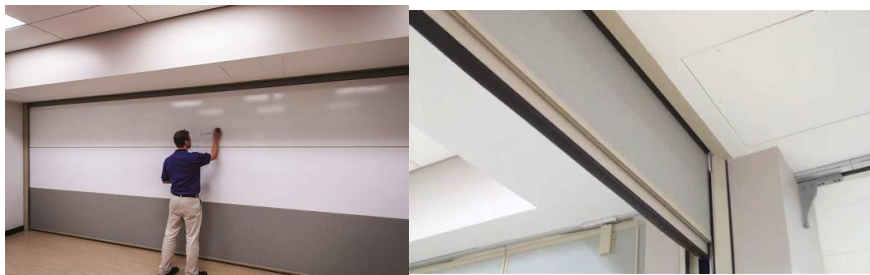
صورة (١٤) نموذج للسقف المعلق المتحرك والذي يستخدم في تخزين القواطع للتحكم في دمج أو فصل الفراغات الداخلية.
