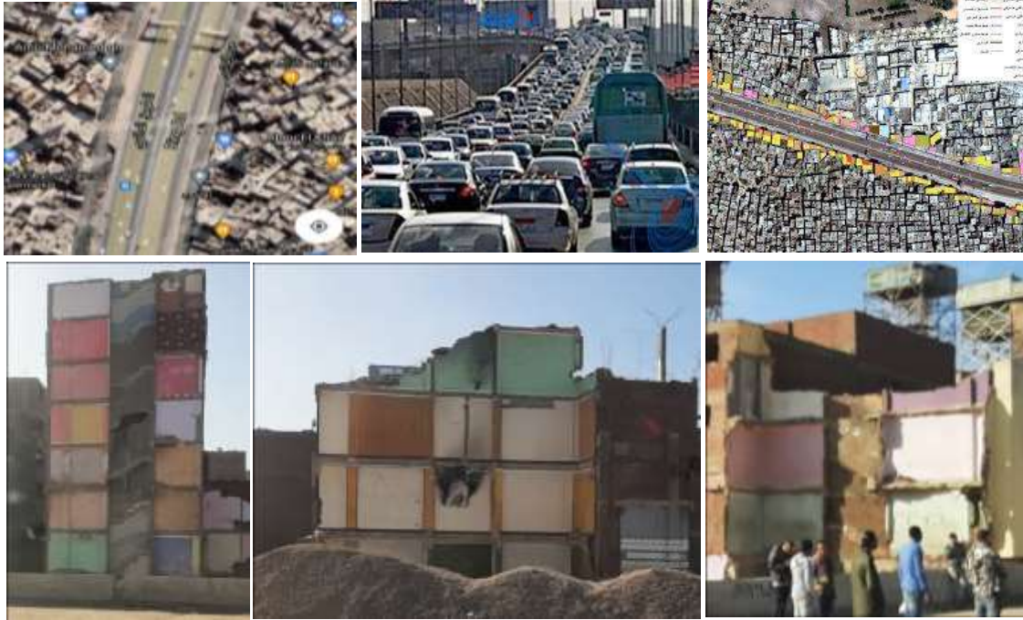
١- صور توضيحية للتكدسات المرورية والأماكن المتاخمة للطريق الدائرى وتوضيح لأعمال إزالة المباني المخافة لأعمال توسعة الطريق الدائرى
