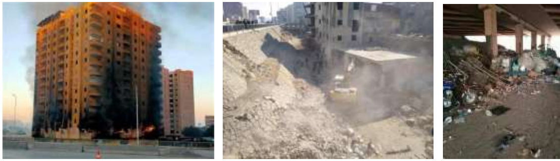
٤- صور توضيحية لمنطقة الكونيسة وحادث الحريق لعمارة منطقة خلف المطبعة المتاخمة للطريق الدائري
