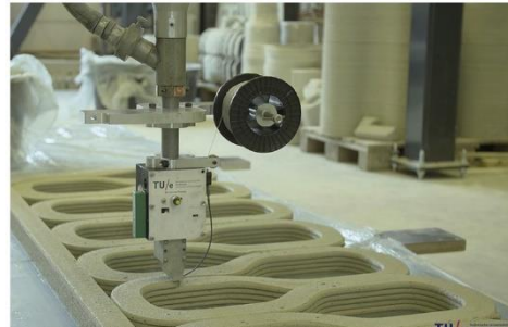
صورة (١): يوضح بثق الخرسانه باستخدام تقنية التلدين الحراري.
