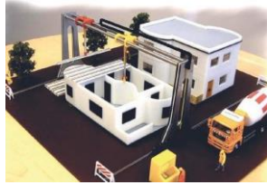
صوره (٢٦): بناء منزل باستخدام تقنية contour crafting https://www.isi.edu/about/history/isi-timeline
