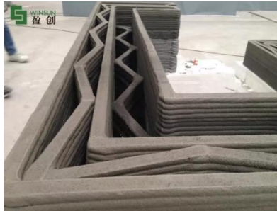
صوره (12): الجدار المجوف، لإضافة مادة العزل في التجويف لجعل الجدار أكثر تأثيرًا في العزل الحراري. http://www.winsun3d.com/En/News/news_in
