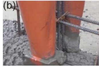
صوره (١٧): دمج التعزيزات الفولاذية التقليدية مع طباعة الخرسانة الهيكلية ثلاثية الأبعاد.
