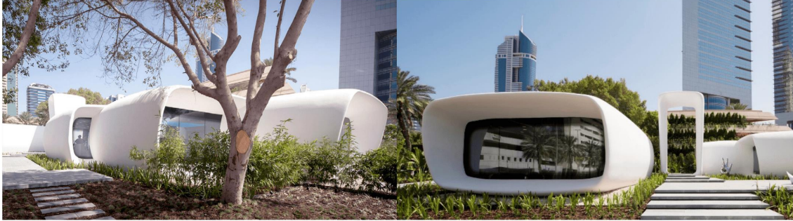
صوره (١٨): مبنى مكتب حكومة دبي تم بناءه باستخدام الطباعة ثلاثية الأبعاد. /https://digital.hbs.edu/platform-rctom/submission/winsun-print-into-the-future
