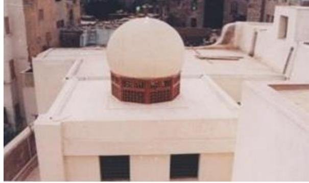
صورته رقم (٢٥): شخشيخة بسقف أحد القاعات ببيت السحيمي وتستخدم للمعالجة الحرارية لخروج الهواء الساخن من الفراغ الذي تعلوه
