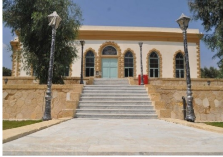
صورة (٢٤): الواجهة الشرقية المصدر: تصوير الباحثة
