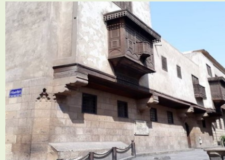
صورة رقم (١٩) الكوابيل في تزيين الواجهات الخارجية لبيت السحيمي وكان يستخدم بشكل زخرفي وله وظيفته الإنشائية المصدر:
