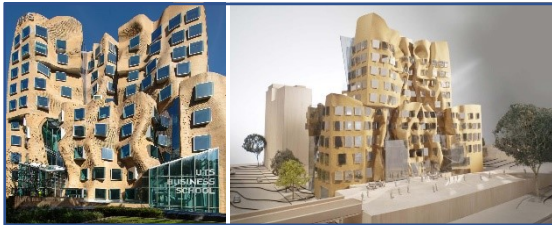
الصورة رقم (٧) Dr. Chow Chak Wing Building مبنى دكتور تشاو تشاك وينج لفرنك جيري في مدينة سيدني في أستراليا (٢١)
