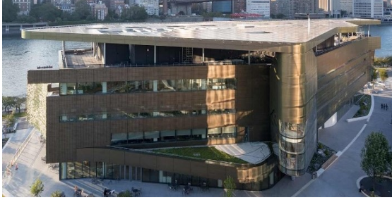
الصورة رقم (١٤) Bloomberg Center مركز بلومبرج في نيويورك، الولايات المتحدة للمعماري مورفوسيس (Morphosis) تم استخدام تقنية التصنيع المطروح في عمل وجهاته (٢٤)
