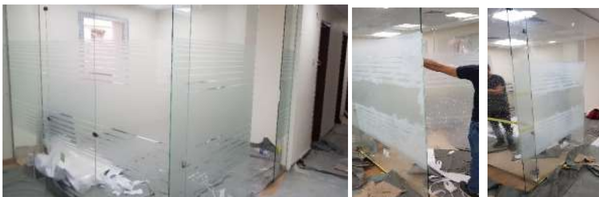
شكل رقم (١٣) مراحل تثبيت الأفرخ اللاصقة لتحسين سطح الزجاج في الفواصل الداخلية ٢
