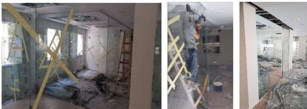
شكل (١١) يوضح مراحل تثبيت الفواصل الزجاجية في الفراغ الداخلي ٢ .
