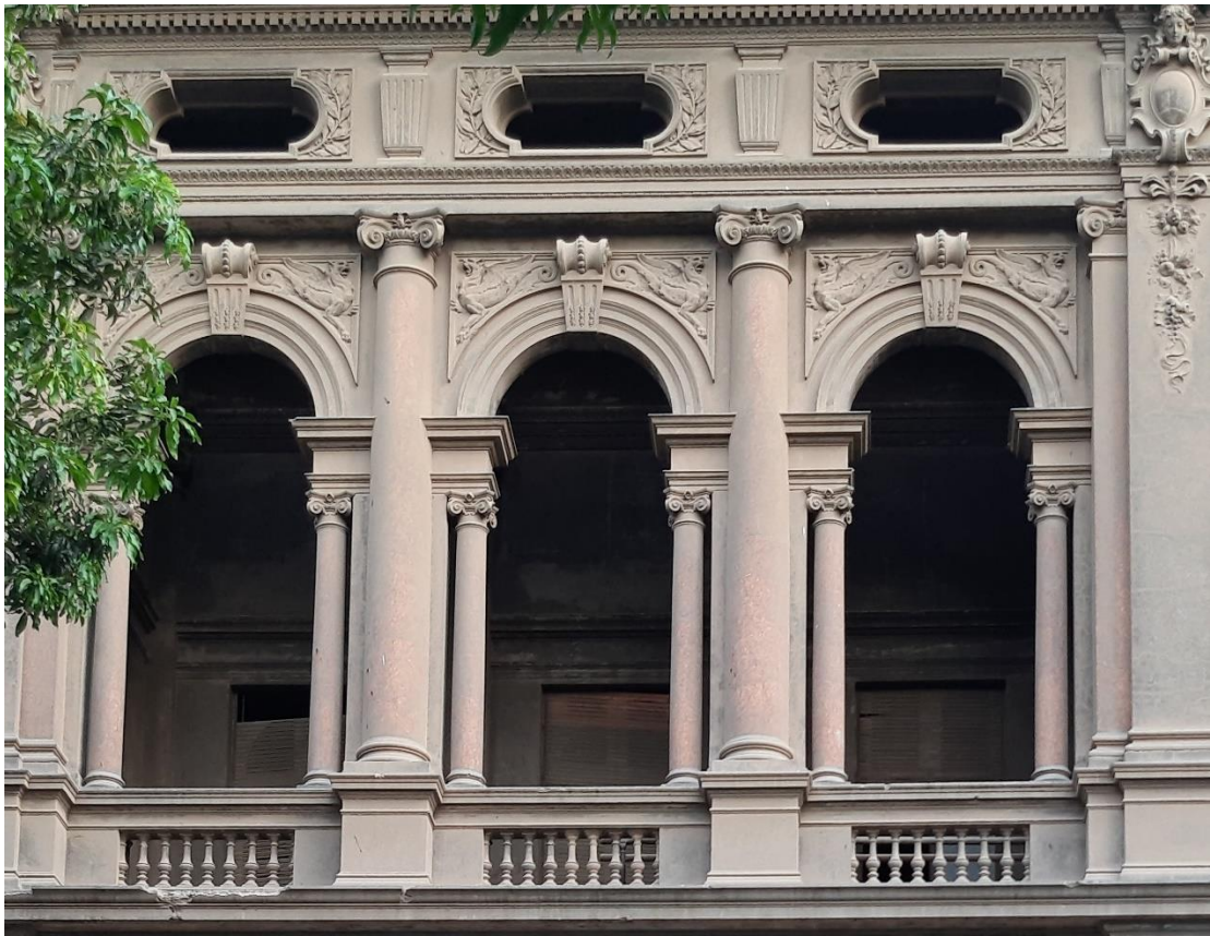
(٣٩) اللوجيا المعقودة في الطابق الثاني من الواجهة الشمالية "تصوير الباحث"
