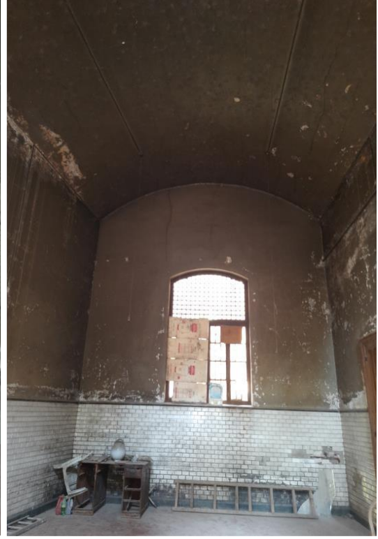
(٣٤) حجرة الجراج الرئيسية من الداخل وبأرضيتها حفرة التنظيف ويتوجها قبو نصف أسطواني وبصدرها نافذة كبيرة بعقد موتور في الضلع الجنوبي ويفتح بها في الضلع الغربي مدخلين كل مدخل يؤدي الي حجرة خاصة بوابور الإضاءة القديم "تصوير الباحث"
