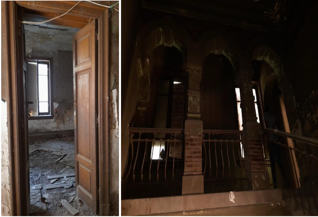
(٢٨) مبني الخدم من الداخل مع تفاصيل لرواقى بواكى صالة سلم المبني في الدور الثاني ونموذج لإحدى حجرات المبني بنفس الدور وتطل على الجهة الشمالية "تصوير الباحث"
