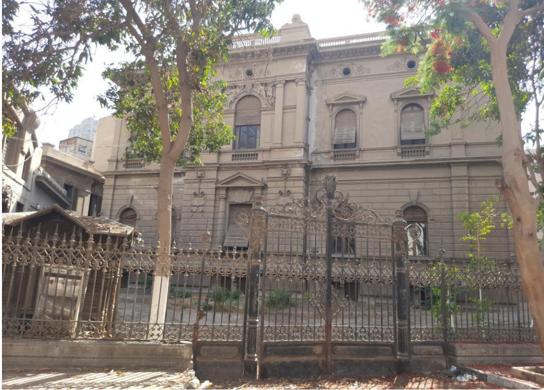
(٩) الواجهة الشرقية والسور الشرقي وبوابته وحجرة البواب "تصوير الباحث"
