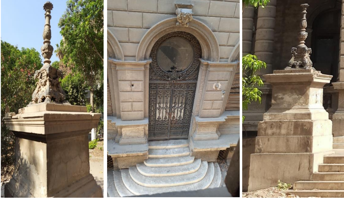
(٤٠) الدعامات "Dado" التي تحمل الشمعدانات في الواجهة الشمالية وبينها صورة المدخل الجنوبي للقصر والدرج الرخامي الأصفر الذي يتقدمه "تصوير الباحث"
