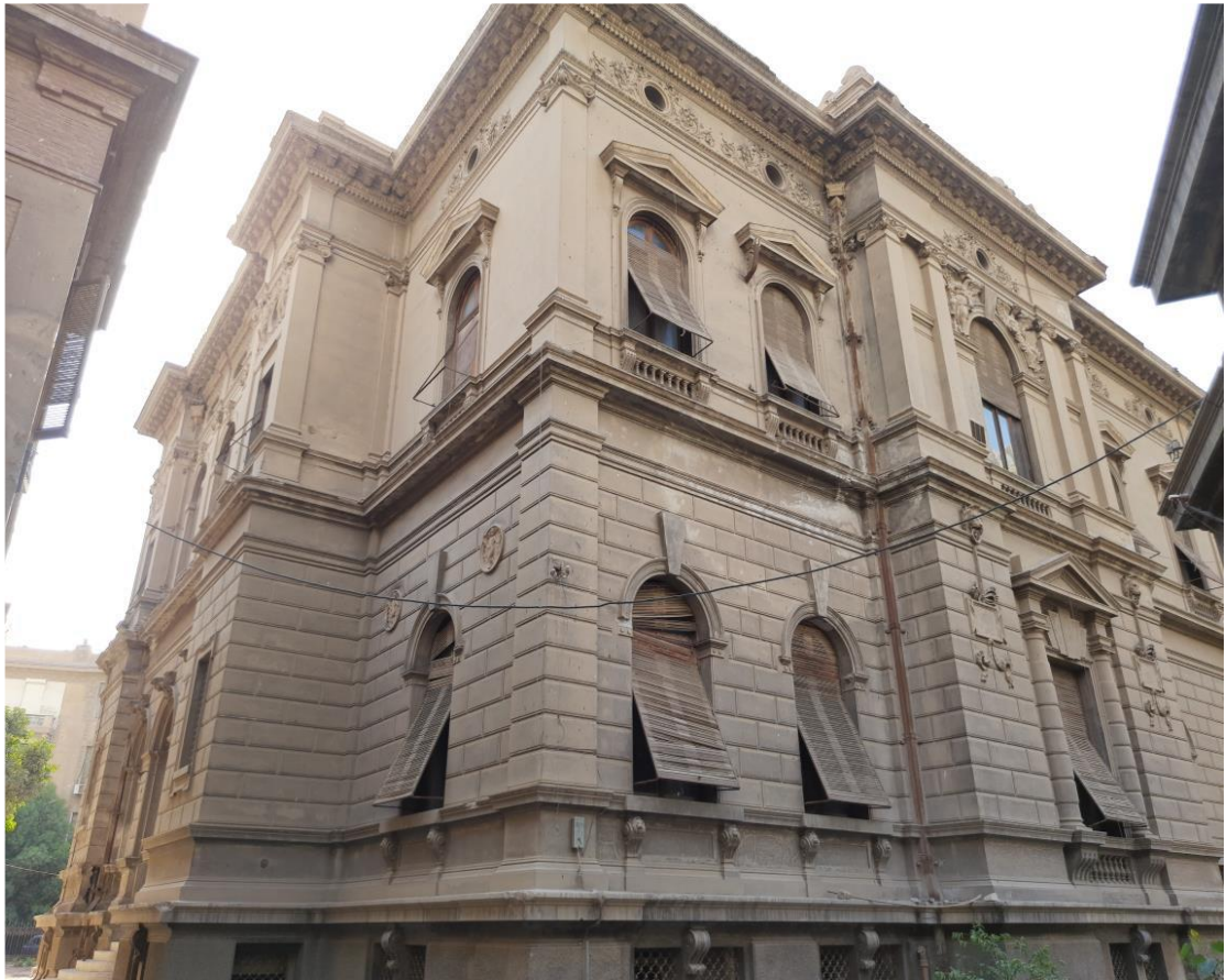
(٢) الواجهة الشرقية مع الجنوبية "تصوير الباحث"
