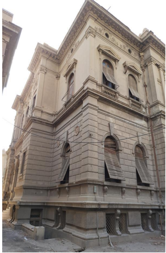
(١) الواجهة الشرقية مع الجنوبية "تصوير الباحث"
