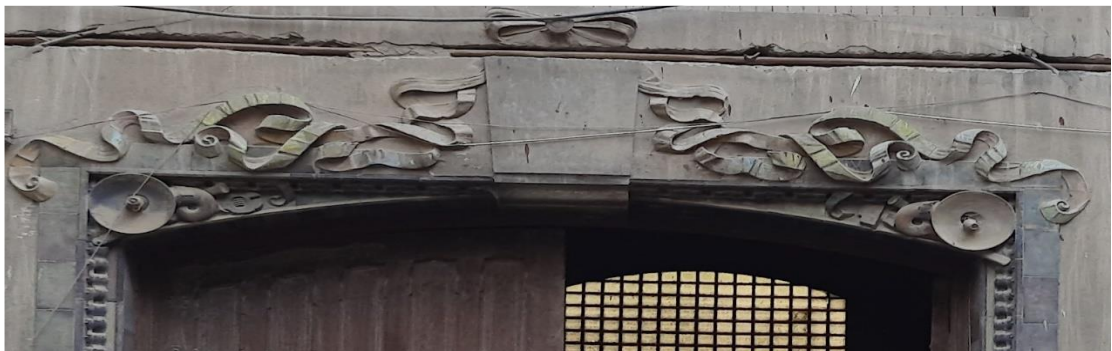
(٥٨) تفاصيل لزخرفة مدخل الجراج بالأربطة والفيونكات أو الفيستونات وسلسلة الجنزير المحيطة بإطار المدخل وفي الوسط كان يوجد قناع اسد بين اطارين من المطاط ولكن سقطوا في الوقت الراهن بالإضافة الي مصابيح الإضاءة في كوشتي العقد وأسفلها مفاتيح حديدية وكل هذه العناصر من عصر الإنشاء وترمز الي أن هذا المدخل مدخل حجرة الجراج تمييزا له عن مدخل حجرة الواور الغربي "تصوير الباحث"
